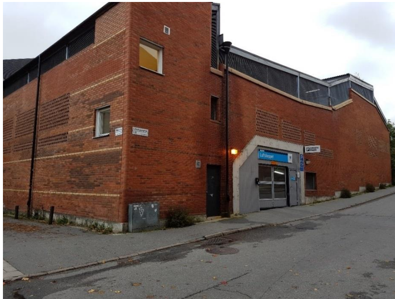
Figur 3 - Flygledaren 3. Stuprör till dagvattennät.
