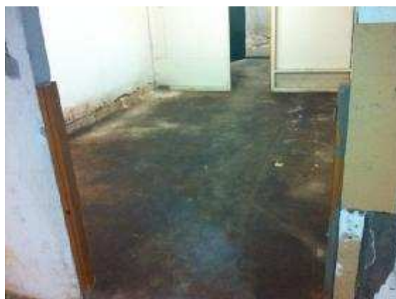
Bild 2. Petroleumkontaminering av betongplatta.
