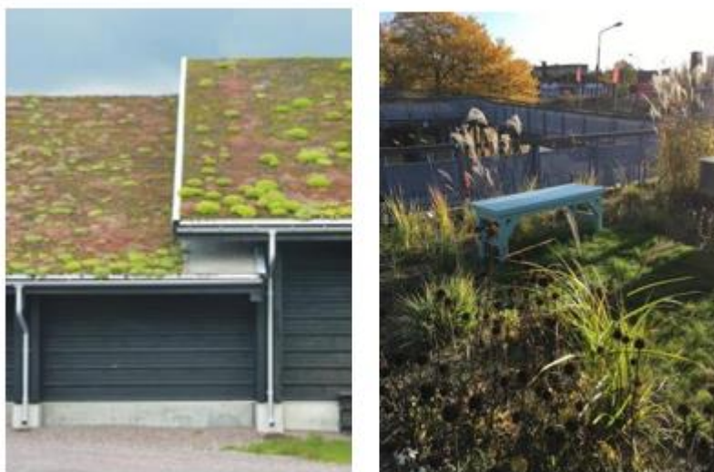
Figur 16. Exempel på olika sedumtak beroende på tjocklek.
