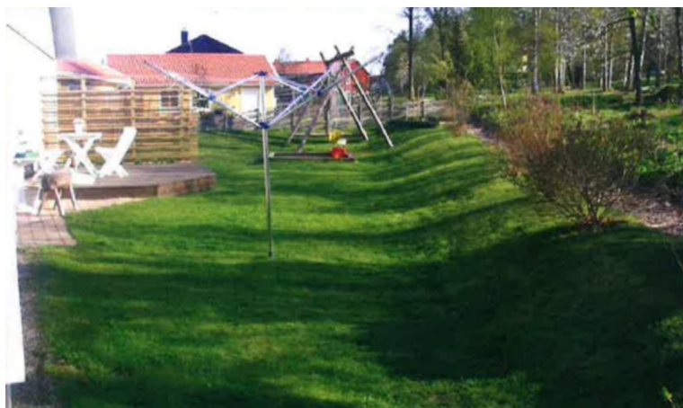
Figur 12. Avskärande dike för dagvattenhantering.
