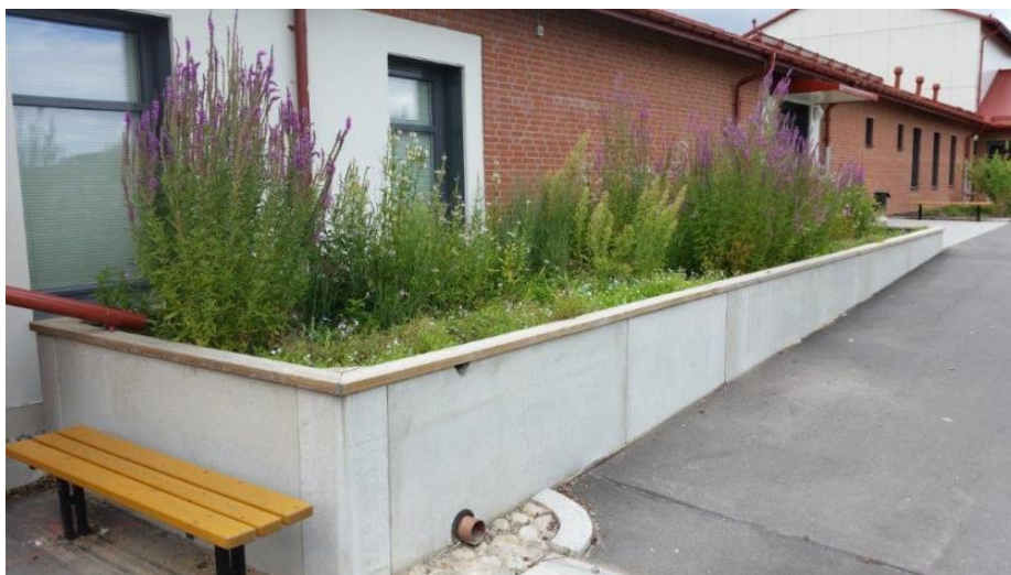
Figur 17. Upphöjt biofilter med utlopp till marknivå.
