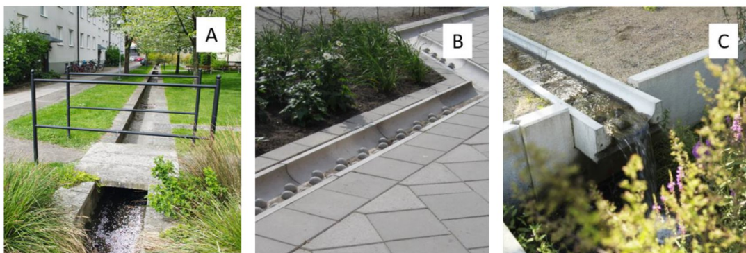
Figur 9. Olika exempel på rännor/öppna kanaler för dagvatten. A: enkel kanal med övergång (Bild av Johanna Sörensen, föreningen Sveriges Stadsbyggare); B och C: mindre kanal i form av lökränna (Bild från S:T Eriks).
