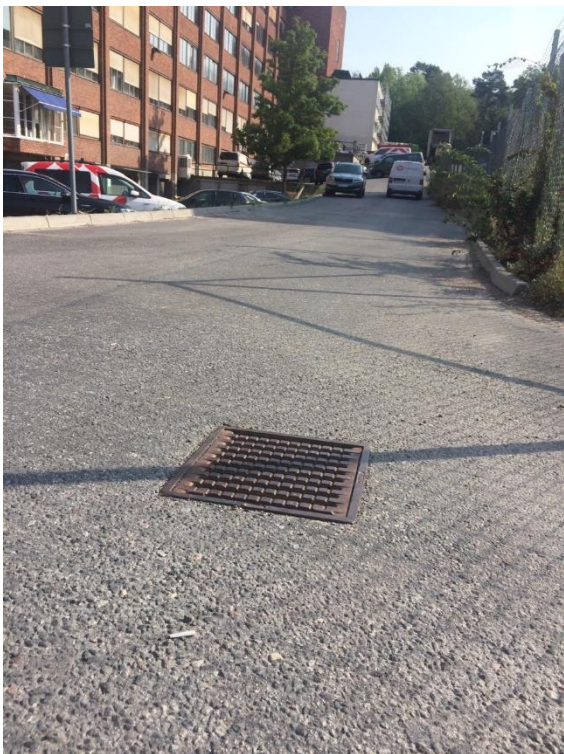
Foto 5. Gallerbrunn för avvattning av infartsväg på sydsidan av byggnaden.
