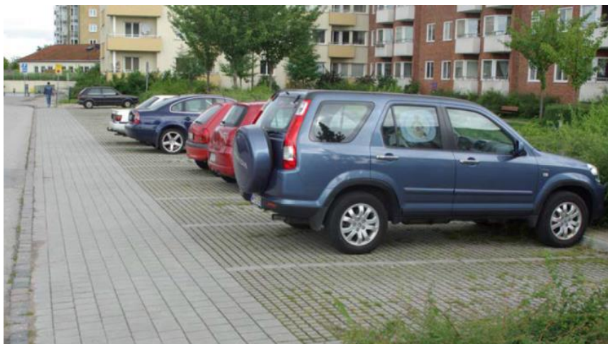
Figur 9. Exempel på genomsläpplig beläggning på parkeringsplats. 8
