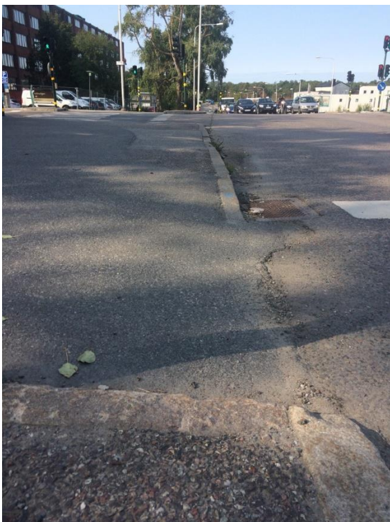
Foto 6. Gallerbrunn för avvattning av Norrbyvägen innan korsning med Voltavägen. Magneten 23 vänster i bild.
