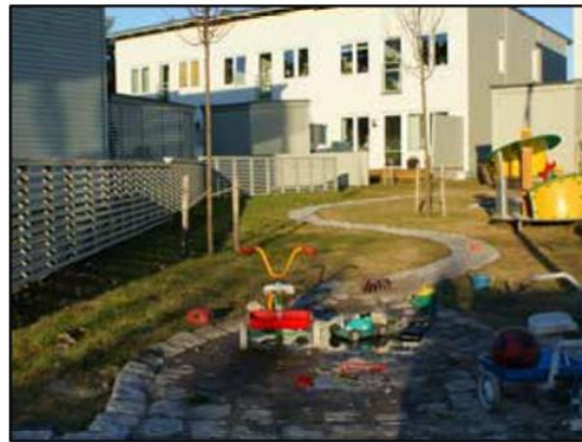
Figur 9-1. Exempel på utformning av avledning av takdagvatten via stuprörsutkastare och rännalarna (t.v.). Till höger visas ett exempel på hur rännalarna i gatsten kan nyttjas för gestaltning av innergård.
