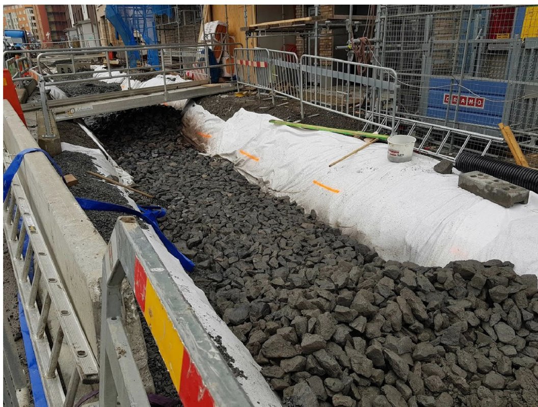
Figur 20. Magasin i form av makadammagasin ovanlagras med kolmakadam
