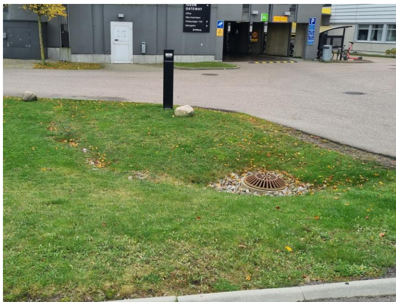
Figur 25 Svackdike med stenkrossdike och bräddavlopp
