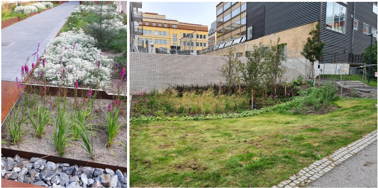
Figur 23 Två exempel på nedsänkta grönytor / planteringar som kan ta emot dagvatten vid regn (N Djurgårdsstaden t.v. och Hammarby Sjöstad t.h.)
