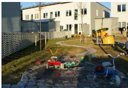
Figur 9 Exempel på ränndalar och ytlig avledning.
