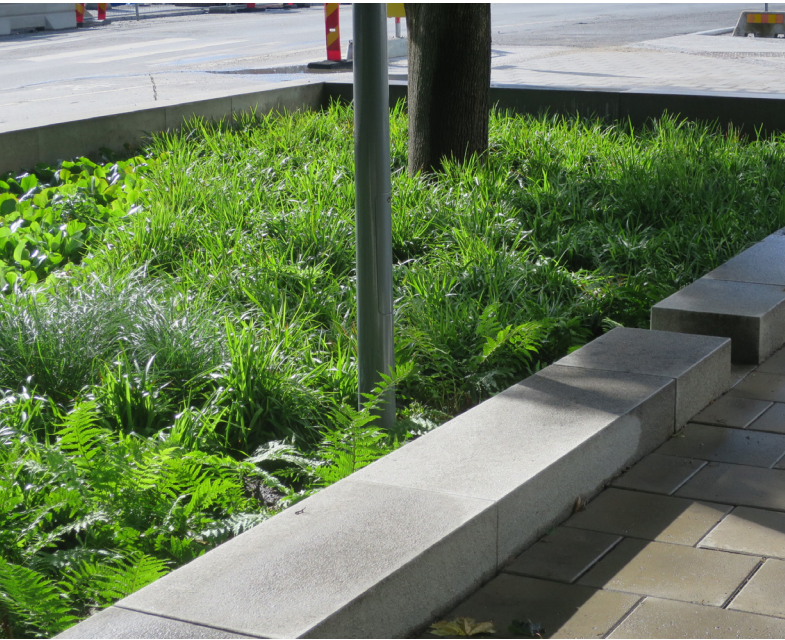
Dagvatten från hårdgjord yta leds ner i plantering
