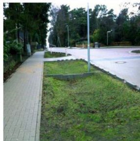
Figur 25. Principskiss samt exempelbild på ett svackdike (Bildkälla: WRS, 2017)
