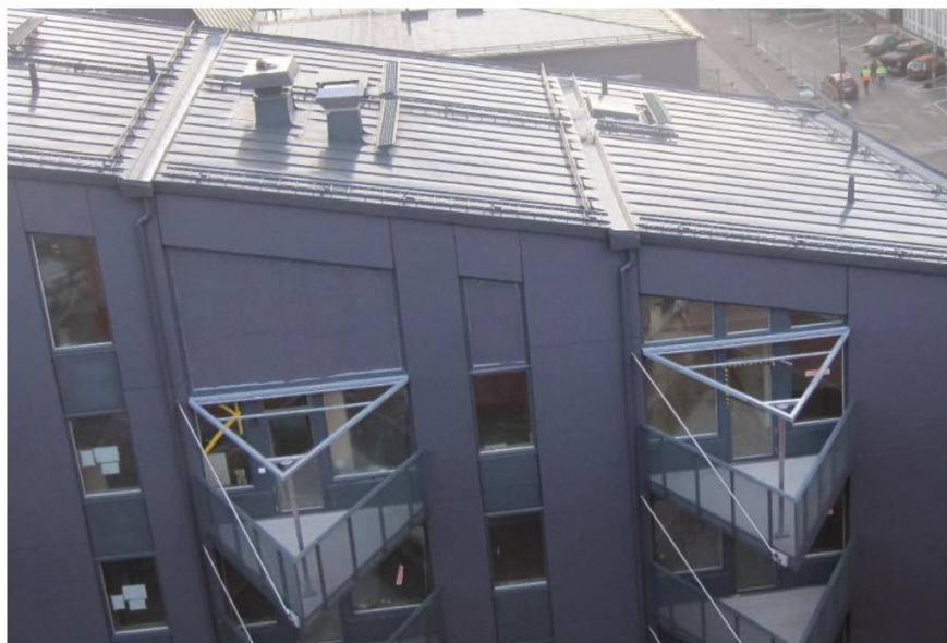
Figur 23. Nedsänkta rännor på taket som kopplas till stuprör för vidare avledning av dagvattnet (Roslagens Plåtkonsult, 2019).
