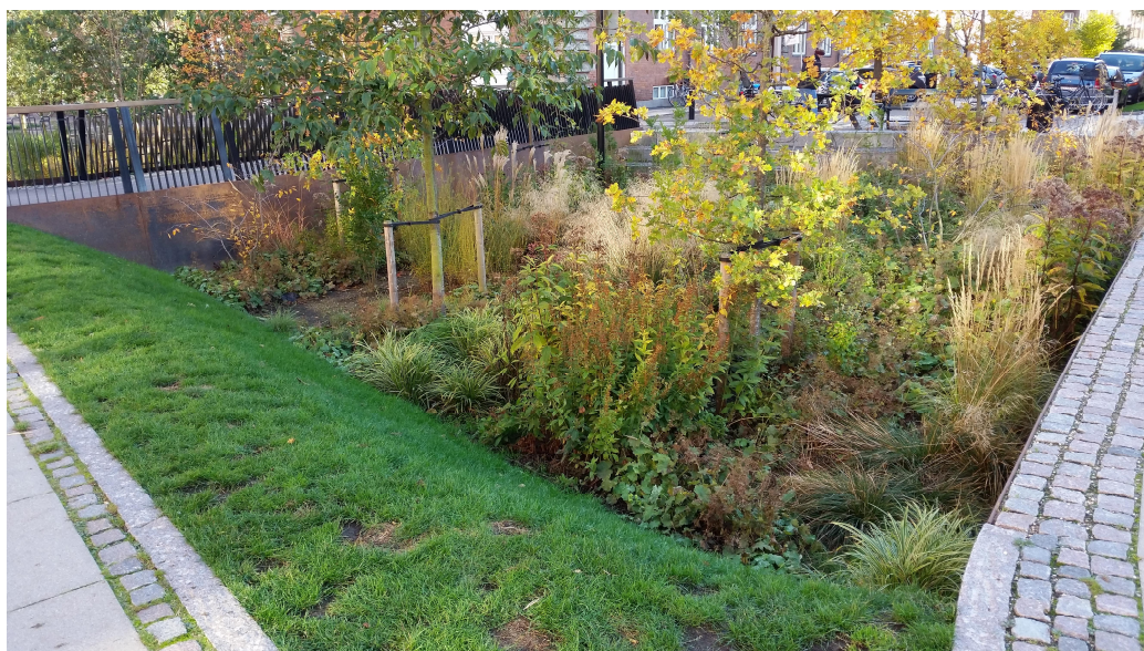
Figur 8 Exempel på nedsänkta utjämningsytor i parkmiljö där vatten kan bli stående för infiltration.
