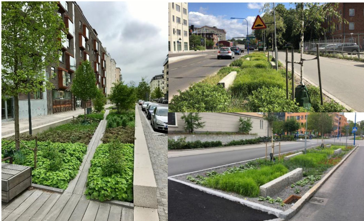
Figur 5-2. Exempel på regnbäddar med trädplantering. Till vänster från Norra Djurgårdsstaden i Stockholm med inlopp genom släpp (håll) i kantsten från gångbana. Till höger visas exempel från Uppsala, överst med inlopp längs nollad kantsten och nederst med specialutformade inloppsbrunnar.
