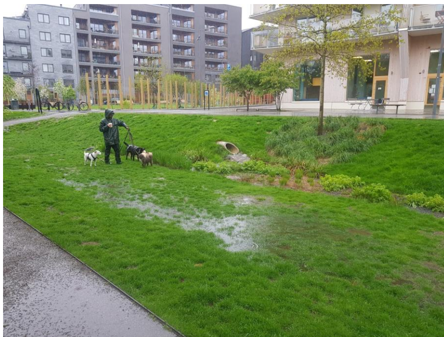
Figur 20. Exempel på översilningsytor på södra sidan av Kvarnbacksvägen. Från Norra Djurgårdsstaden 2021-05-26 efter ca 40 mm nederbörd under 12 timmar.
