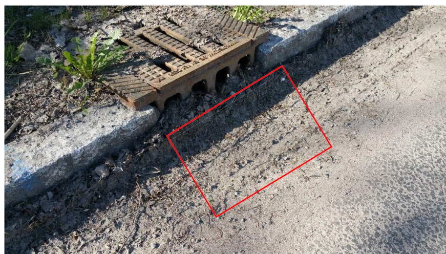
Figur 17. Exempel på skelettjordar och nedsänkta växtbäddar som det kan se ut längs Linta gårdsväg, med brunn DB3. Observera att brunnar kommer att ha intag även i gata (röd yta).
