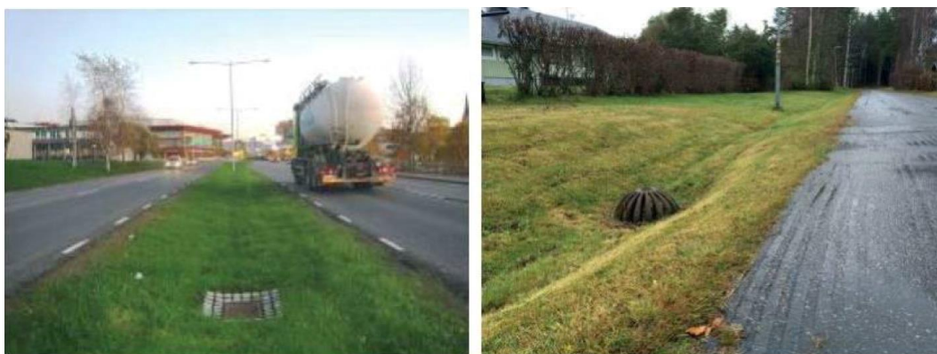
Figur 26. Två exempel på svackdiken (Svenskt Vatten Utveckling, 2019).
