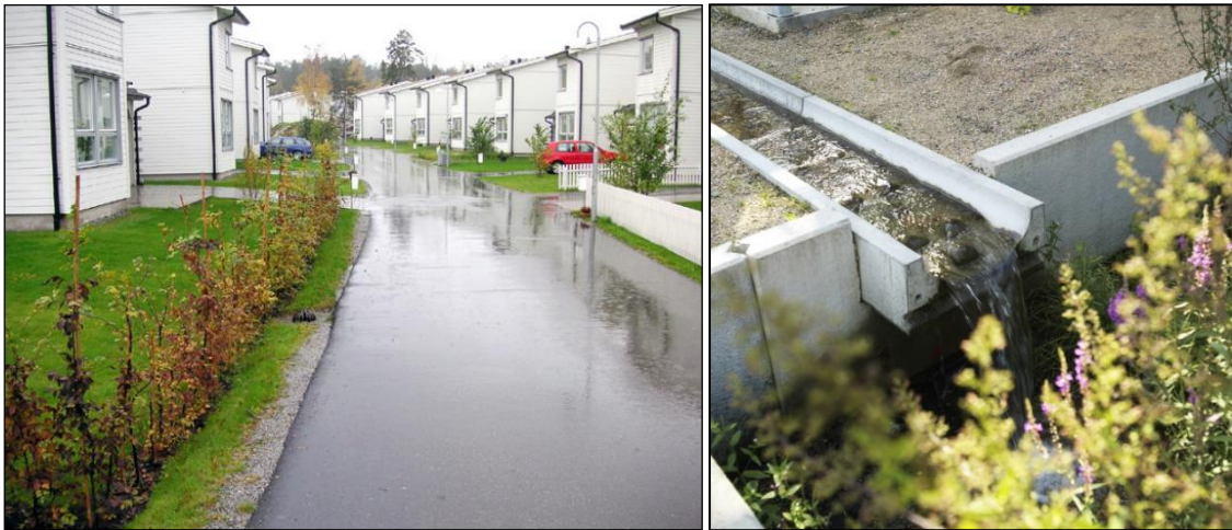
Figur 9-2. T.v. Exempel på utformning av avledning av dagvatten från hårdgjorda ytor till planteringar, där dagvattnet infiltrerar i ett poröst lager (Stockholm Vatten & Avfall, 2021b). T.h. Rännor som avleds till en nedsänkt plantering ( https://steriks.se/produktsortiment/markbelaggningsplattor/lokrannan/ ).
