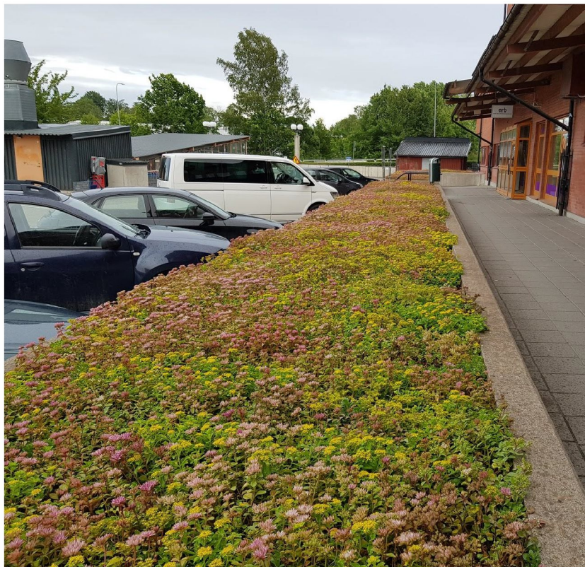
Figur 22 - Ekerö Centrum, garagebjälklagstak. Sedummatta, standard/original, tjocklek 30mm (bild: Sweco).
