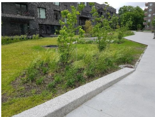
Figur 14. Exempel på nedsänkta växtbäddar för omhändertagande av t.ex. takdagvatten.
