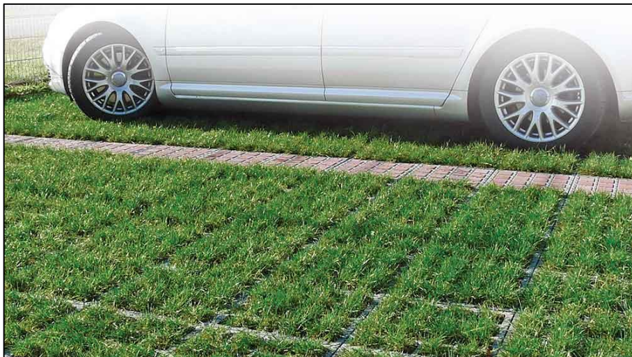
Figur 10-7. Exempel på genomsläpplig beläggning med armerat gräs (Miljöbarometern Stockholms Stad, 2022).
