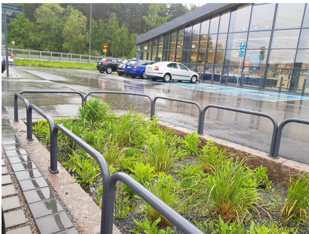
Figur 22. Nedsänkt växtbädd i Sigtuna. Inget utflöde kunde konstateras i bräddbrunnen/utloppsbrunnen trots att 1000 kvadratmeter ligger uppströms växtbädden. 2021-05-26 efter ca 40 mm nederbörd under 12 timmar.
