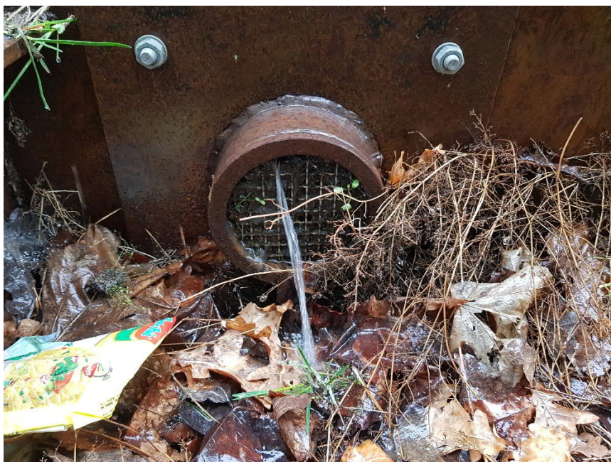
Figur 19. Norra Djurgårdsstaden, växtbädd vid regnet 2021-05-26. Galler samlar skräp, blad och dylikt och täpper för utloppet till nedsänkt växtbädd (se kryss nedan för foto-placering).
