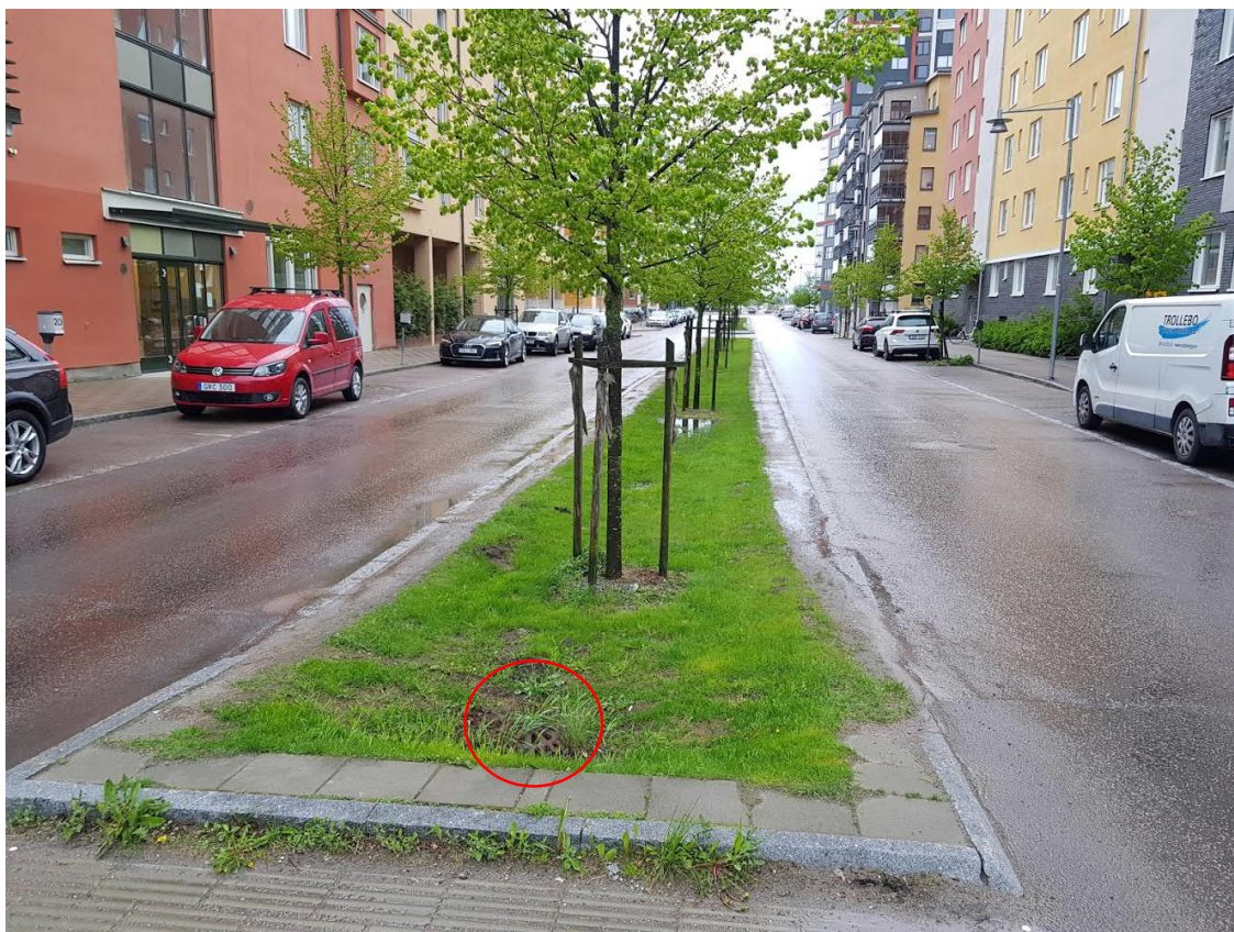
Figur 30. Dagvattenbrunn med kupolsil, DBK. Används tillsammans med plantering av gräs eller äng längs flera vägsträckor. Längs gata alltid i kombination med genomsläpplig skelettjord och dräneringsledning som kopplas till DBK med sandfång. Används även i parkerna. Bild från Västerås.
