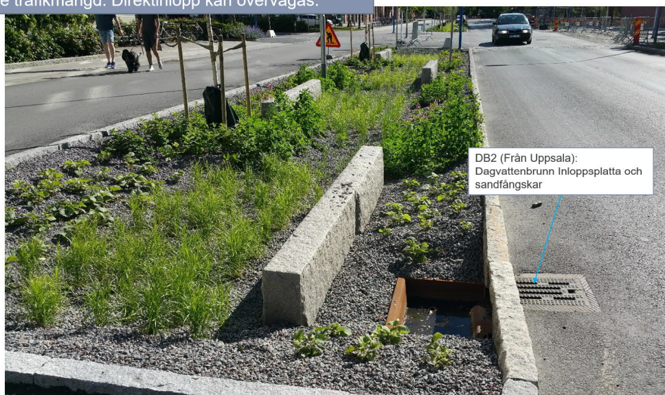
Figur 27. Bevattningsbrunn enligt Uppsalas modell. Kan kombineras med helt släpp i kantsten. För lågtrafikerade lokalgator, även kallade parkgator.
