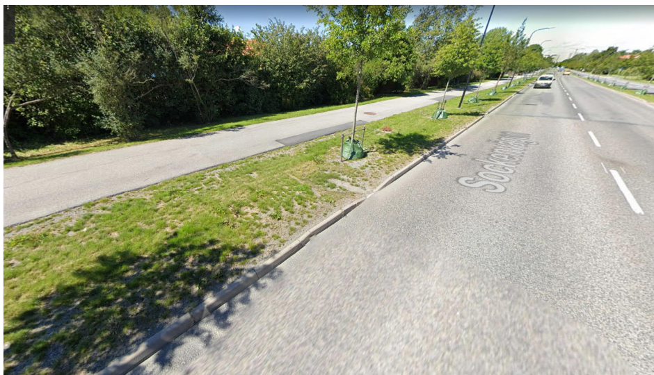
Figur 34. Dike med släpp från väg med nedsänkt kantsten (Sockenvägen, Google Street view).
