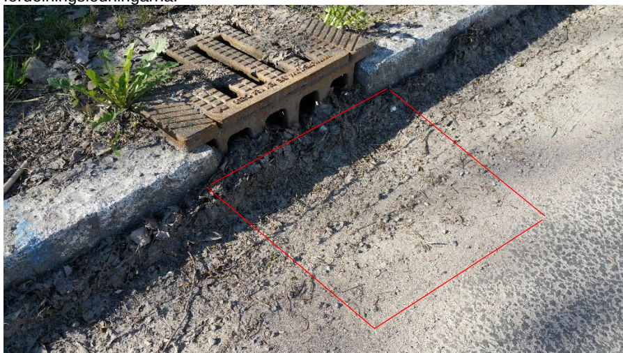
Figur 32. Exempel på skelettjordar och nedsänkta växtbäddar som det kan se ut längs Linta gårdsväg, med brunn DB3. Observera att brunnar kommer att ha intag även i gata (röd yta).
