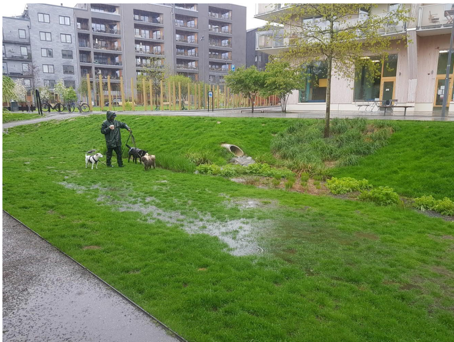
Figur 35. Exempel på översilningsytor på södra sidan av Kvarnbacksvägen. Från Norra Djurgårdsstaden 2021-05-26 efter ca 40 mm nederbörd under 12 timmar.
