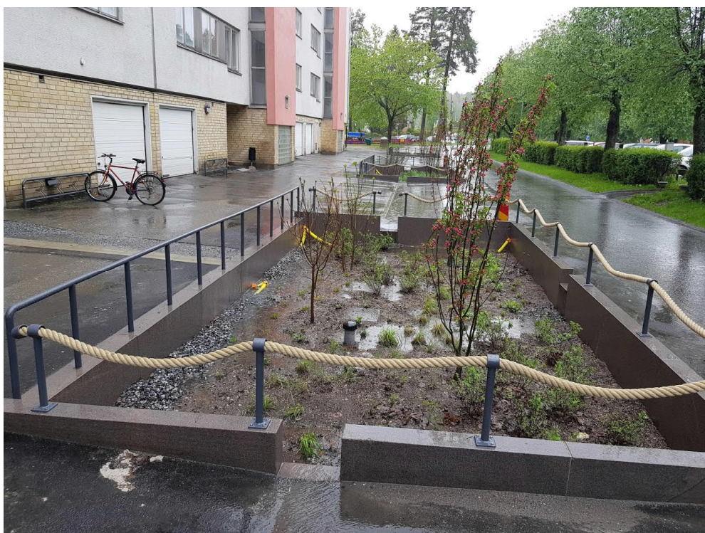
Figur 21. Nedsänkt växtbädd i Södertälje vars gatudagvatten leds ned i växtbädd genom släpp i stödmur. 2021-05-26 efter ca 40 mm nederbörd under 12 timmar.
