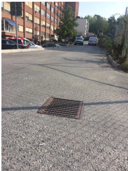
Foto 5. Gallerbrunn för avvattnings av infartsväg på sydsidan av byggnaden.
