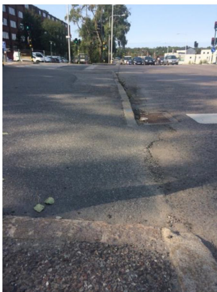
Foto 6. Gallerbrunn för avvattnings av Norrbyvägen innan korsning med Voltavägen. Magneten 23 vänster i bild.
