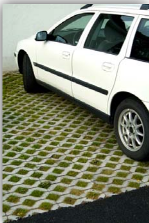
Bild 8. Gräsarmering till parkeringsytor (S:t Eriks 2021-04-30)
