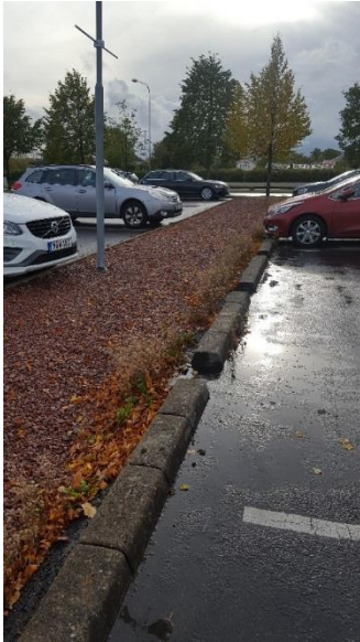
Figur 11 T.v. Möjlig utformning av makadamstråk i anslutning till parkeringsyta. Källa: Ramböll. T.h. Exempel på makadamdike mellan lokalgata och tomtmark. Källa: WRS (SVOA, u.d.).
