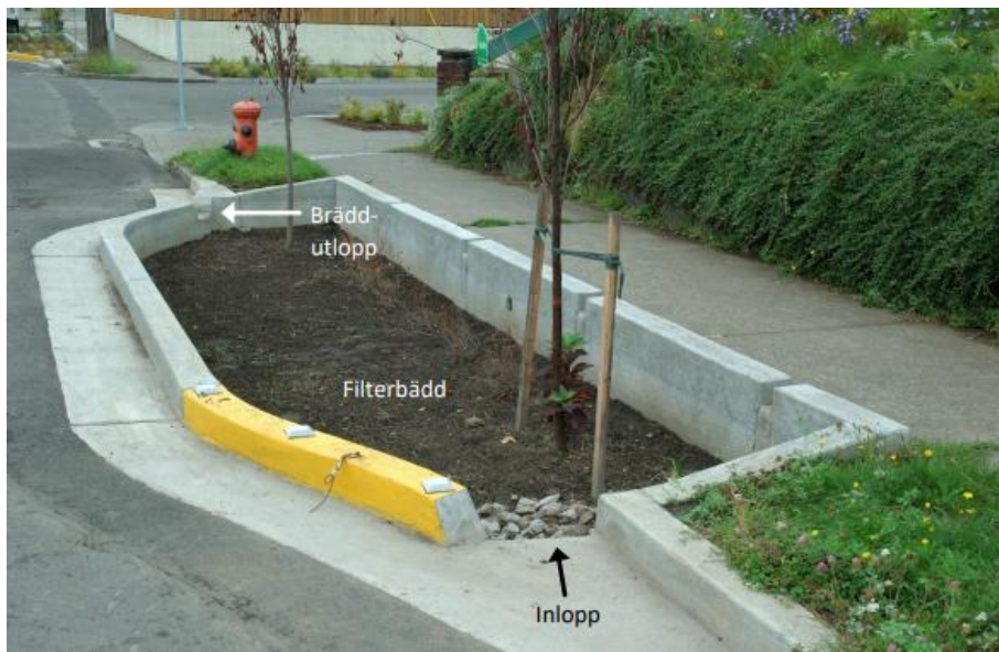
Figur 24. Biofilter med stenskravel som erosionsskydd vid inloppet och bräddutlopp i form av en slits i kantstenen (Pramsten, 2021).
