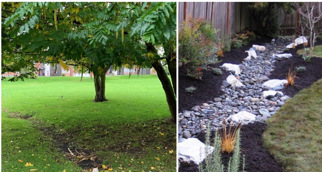
Figur 14. Exempel på avskärande dike/lågstråk i grönområde (t v) samt intill byggnad (t h). Foto: Bjerking AB.
