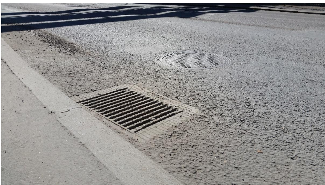
Figur 8 - Dagvattnet i området avvattnas med hjälp av konventionella rännstensbrunnar.
