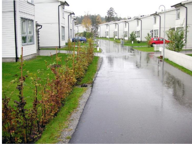
Figur 12 T.v. Möjlig utformning av makadamstråk i anslutning till parkeringsyta. Källa: Ramböll. T.h. Exempel på makamdikey mellan lokalgata och tomtmark. Källa: WRS (SVOA, u.d.).
