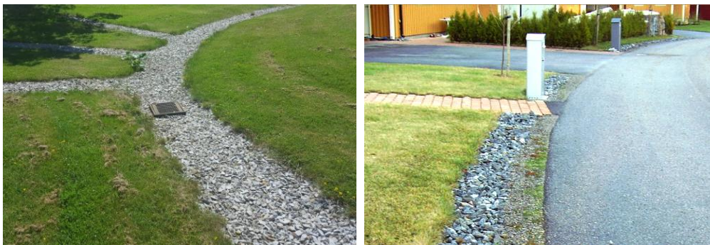
Figur 17. Exempel på makadamdiken. Källa: Ramboll, 2016 & SVOA, u.d.
