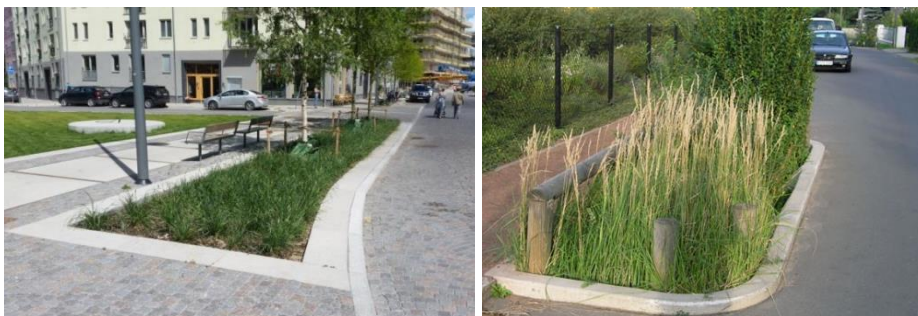
Figur 16. Exempel på utformning av nedsänkta växtbäddar. Källa: SVOA, u.d.
