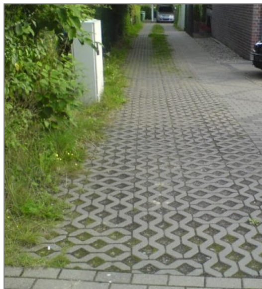
Figur 6-9. Exempel på genomsläpplig beläggning i form av gräsarmerad betongbeläggning (Stockholms Vatten och Avfall, 2017).
