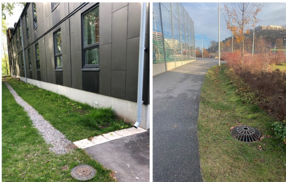
Figur 22. Exempelbilder på utvändig avledning av takvatten via utkastare till makadamstråk (tv) samt avledning via grönt lågpunktsstråk (th). Foton tagna av Bjerking AB.
