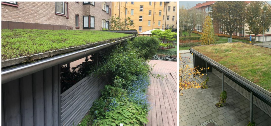
Figur 21. Exempelbilder på skärmtak med växtlighet. Vid tillfällen då växtligheten och jorden är mättad samlas vatten upp i hängränna. Foton tagna av Bjerking AB.
