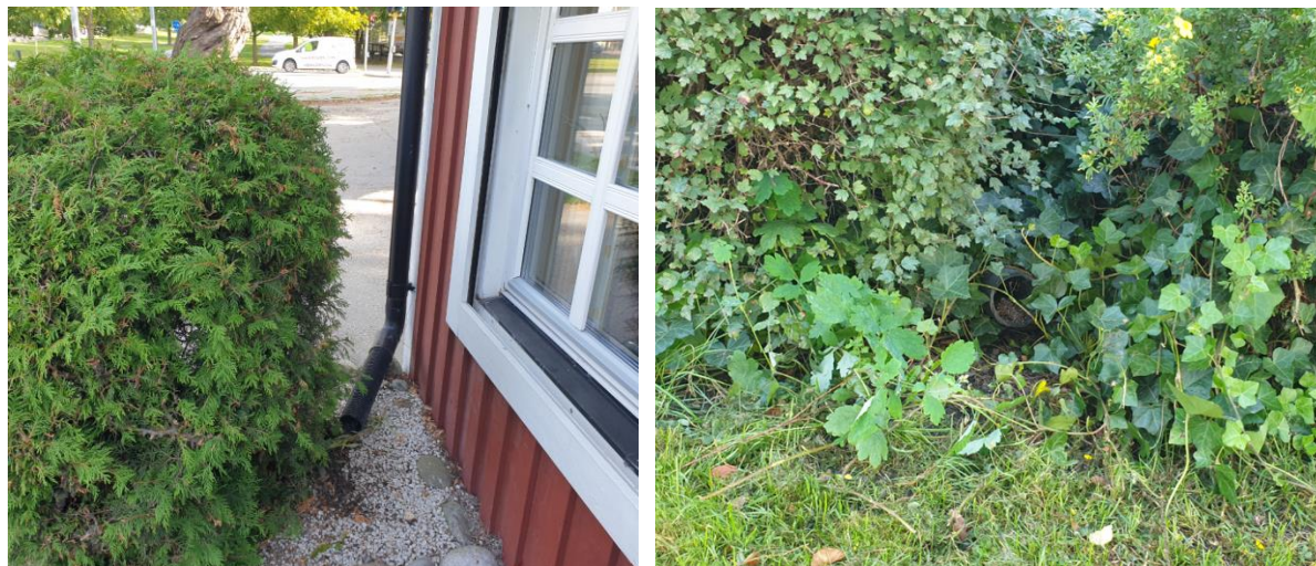
Figur 14 Utkastare leder dagvattnet ytligt till rabatter på byggnadens västra sida
