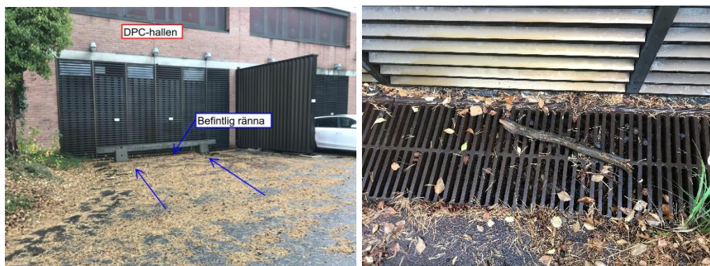
Figur 25. Befintlig lågpunkt söder om DPC-hallen. Dagvatten från parkeringen mellan Ormen långa och DPC-hallen rinner mot rännan vid DPC-hallen. Här kan det bli problem vid skyfall när rännan fylls.
