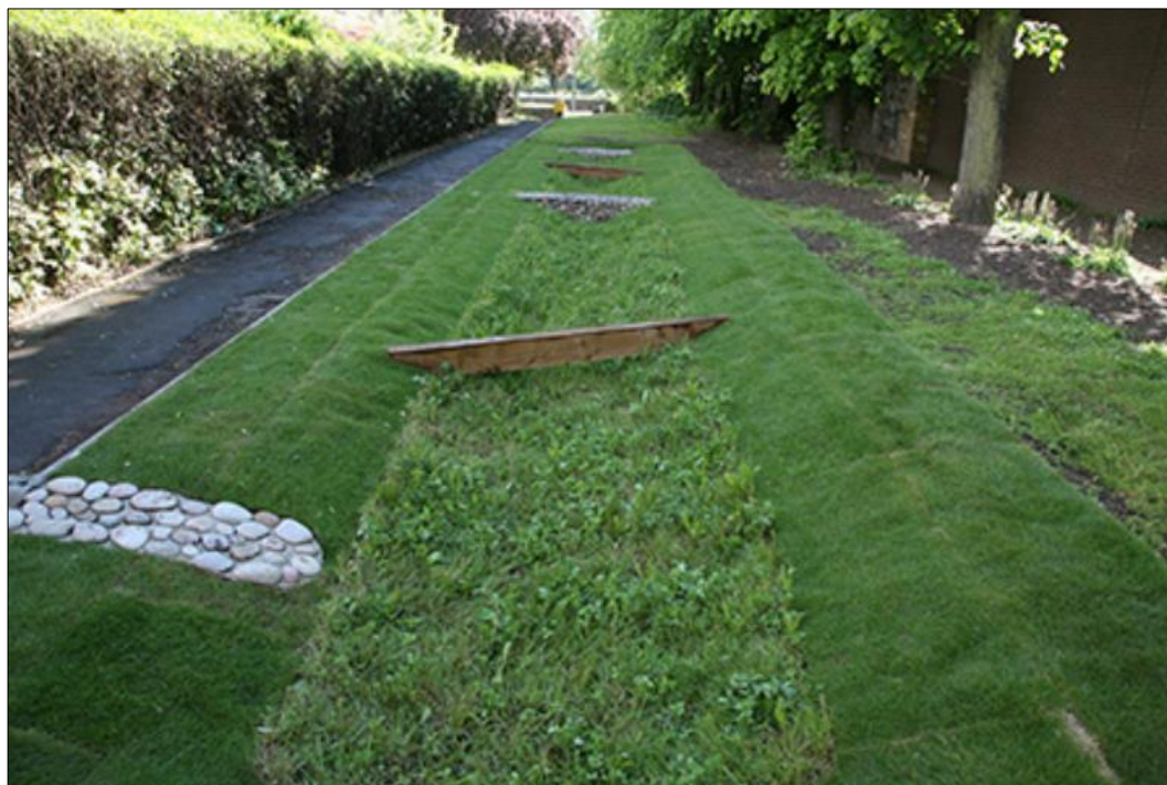
Figur 14. Exempel på utformning av svackdike (källa: Rent dagvatten).
