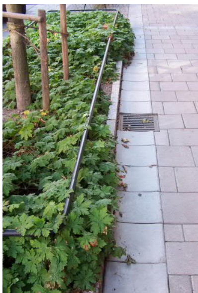
Figur 23. Vänstra bilden visar en vanlig rännstensbrunn som leds till skelettjorden intill. Högra bilden visar träd planerade i skelettjord på Erik Dahlbergs allé (Bildkälla: Stockholm vatten och avfall)
