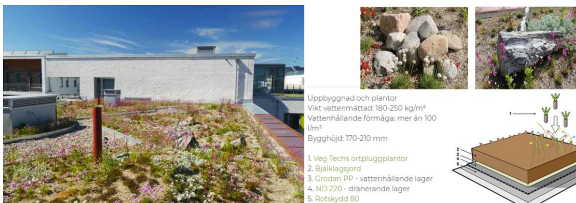
Figur 11. Exempel på strandängs-biotoptak från fastigheten Koggen i Malmö (foto: Grönatakhåndboken) samt möjlig uppbyggnad (illustration: Vegtech).
