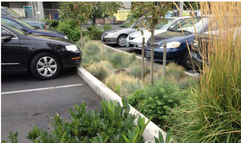
Figur 11 Exempel på nedsänkt växtbädd i parkering. I denna anläggning leds dagvattnet in i växtbädden via öppningar i kantstenen. Bild från Stockholm Vatten och Avfall (SVOA, 2019).
