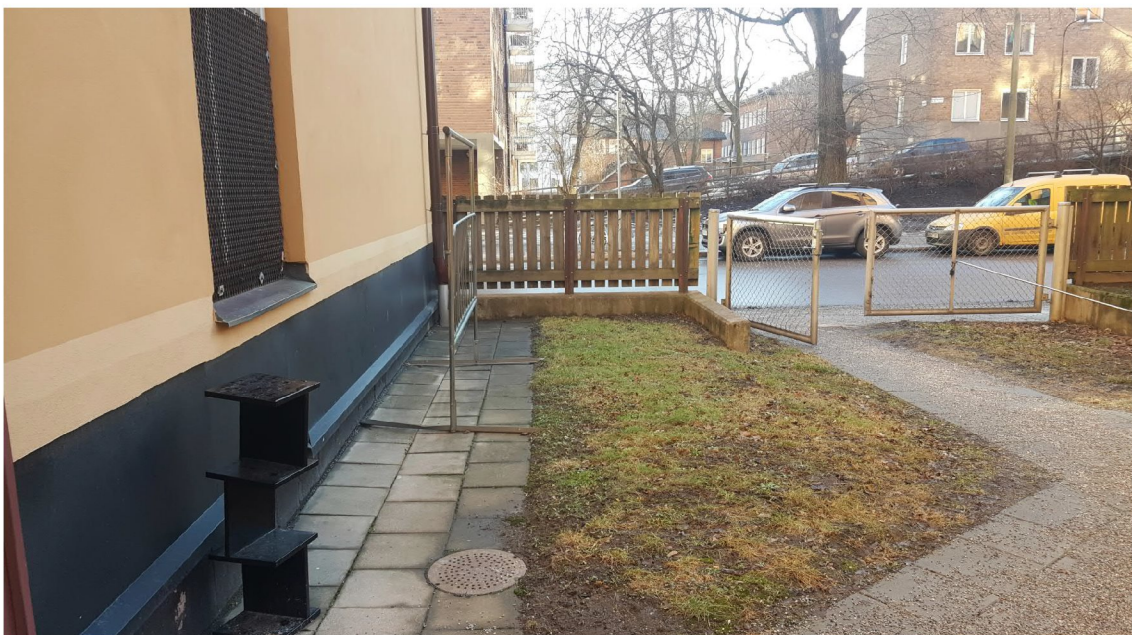
Figur 2. Fotografi taget mot söder/Högbergsgatan. Stuprör och brunn ansluter till ledning mot Högbergsgatan.
