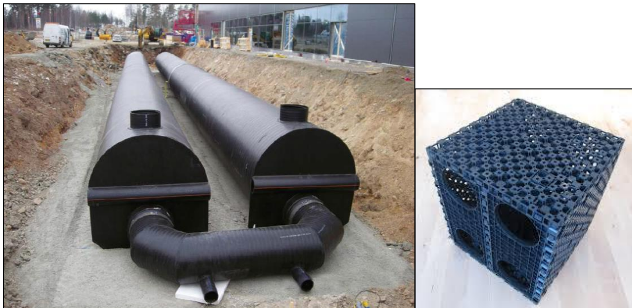
Figur 5-6: Fördröjningsmagasin i plast, i form av rörmagasin (vänster) och plastkassetter (höger).
