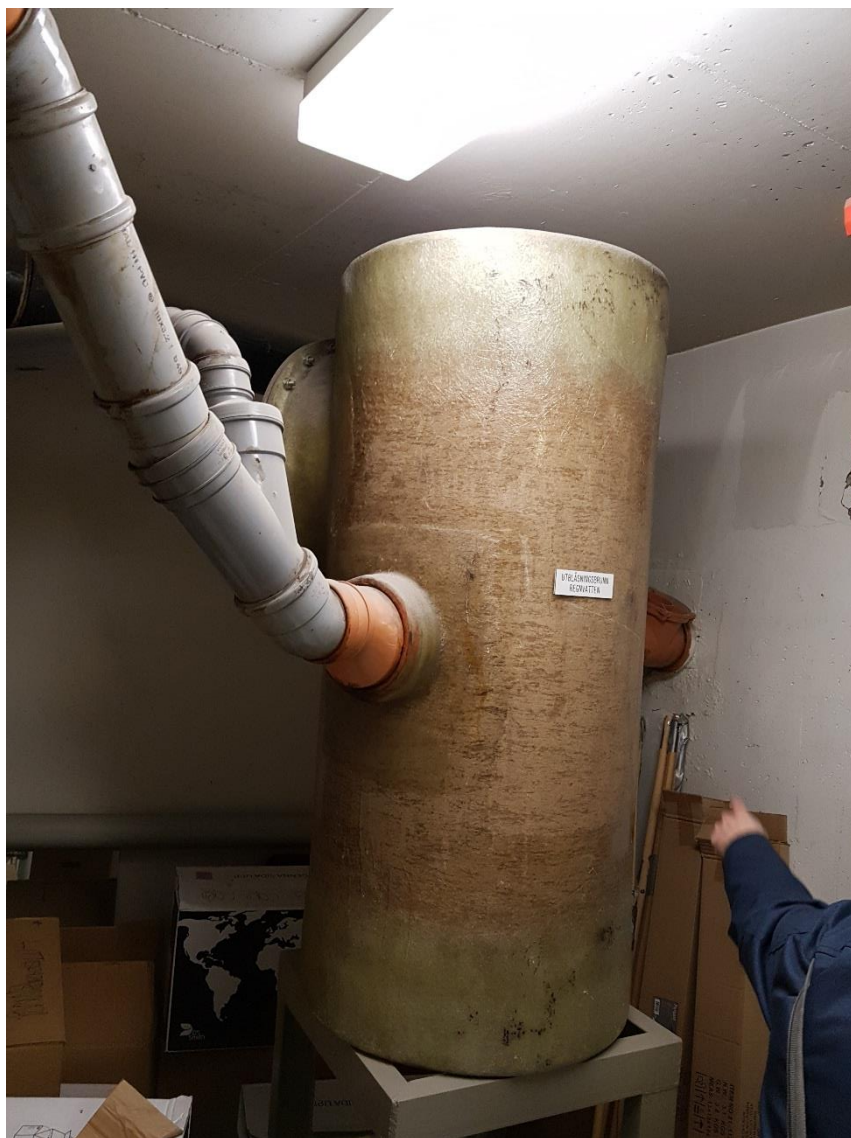
Figur 5: utblåsningsbrunn på plan 1 i garaget
