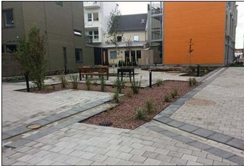
Figur 11. Exempel på ytlig avledning av takvatten till växtbädd via stensatt rännal i Vallastaden, Linköping (Movium 2017).
