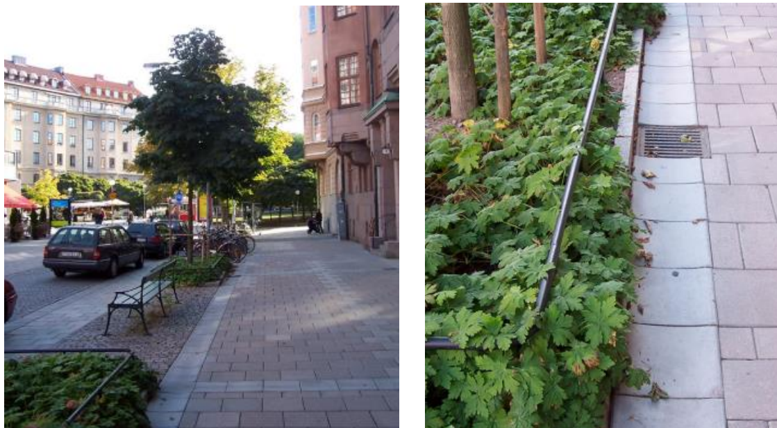
Figur 17. Träd planerade i skelettjord på Erik Dahlbergsallén med anslutande rännstensbrunn (Bildkälla: Stockholm vatten och avfall)
