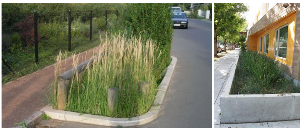
Figur 14. Exempel på en nedsänkt växtbädd i gatumiljö samt en delvis upphöjd växtbädd i förgårdsmarken till en byggnad (Stockholm vatten och avfall, 2017).
