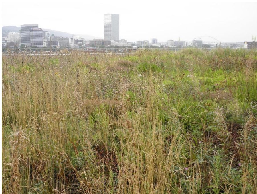
Figur 11 – Grönt tak med ängsväxter, för rening och fördröjning av nederbörd. Foto från Portland, taget av Sweco 2010
