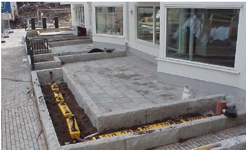
Figur 8c Takvattenutlopp till infiltrationskassetter/spridningsmagasin. Kan tillämpas då direktutledning till omgivande mark inte är möjlig (hus 1). Lösningen ger vattentillskott till planteringsyta, samt ett fördröjande avrinningsförlopp. Anordningen kräver väl-dränerat underliggande material och bräddfunktion.
