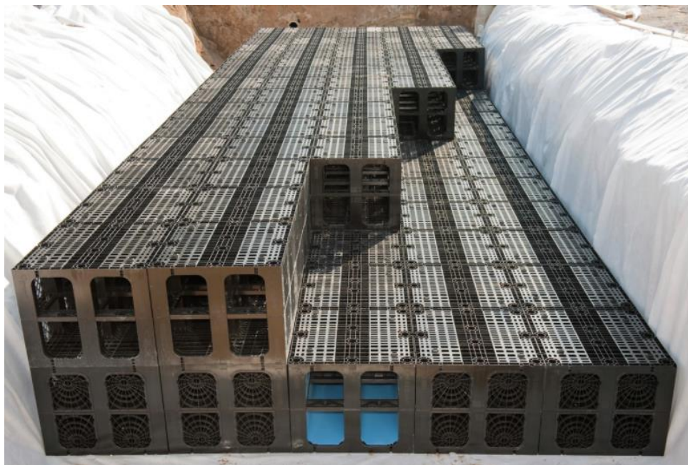
Figur 5. Exempelbild på dagvattenkassetter och hur dessa kan placeras.
