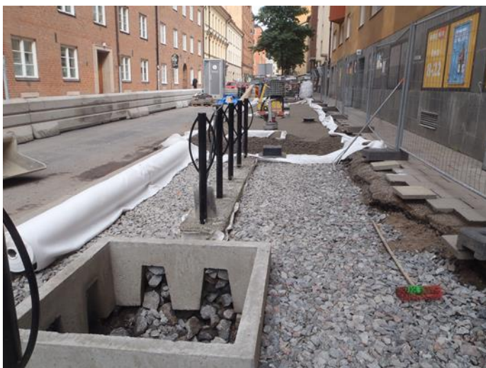
Figur 11 Exempel på etablering av skelettjord i befintlig miljö i Stockholm. Foto Björn Embrén Trafikkontoret.
