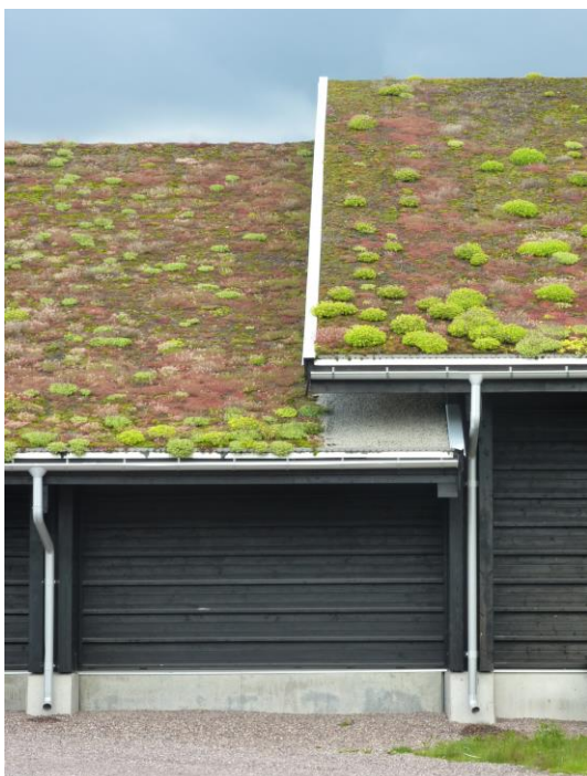
Figur 9 Exempel på tunt grönt tak. Foto: WRS
