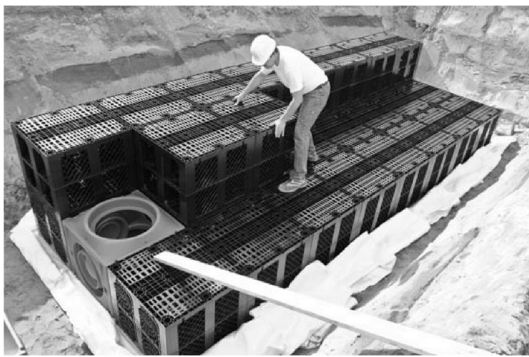
Figur 7: Dagvattenkassetter (www.rehau.com)
