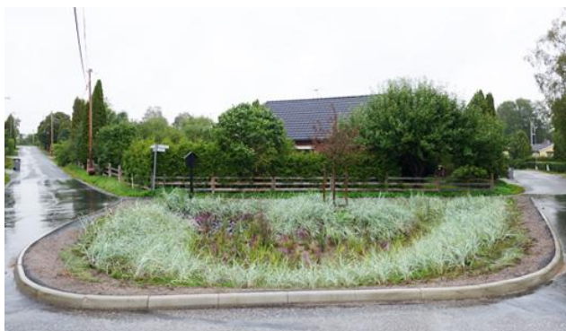
Figur 7. Rain garden/biofilter i bostadsområde, Tyresö (Veg Tech AB)
